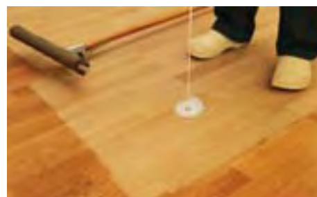
Auftragen von «Hartwachs flüssig» auf einen Holzboden
